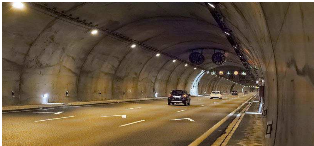
La compañía cuenta con más de 26 kilómetros repartidos en estas infraestructuras.
