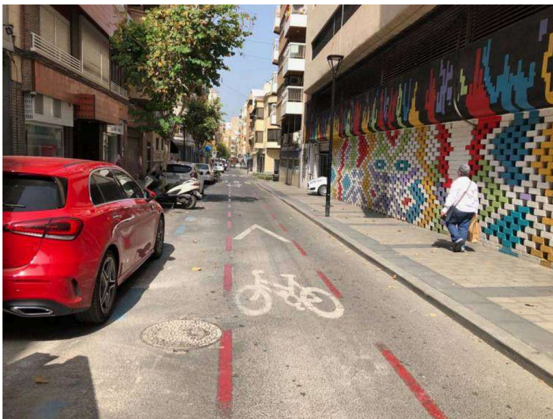
Las marcas viales que delimitan una vía ciclista en la calle Poeta Quintana.
