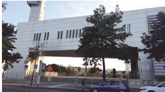
Fachada de la Dirección General de Tráfico en Málaga. ALICIA MATAS
