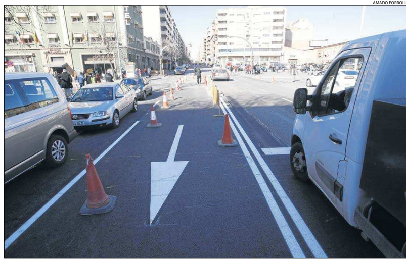
Vehículos pasando por el único carril en dirección al puente Príncipe de Viana abierto ayer.
